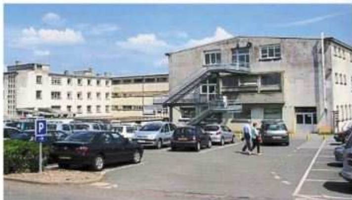
Une importante modernisation de l'hôpital de L'Aigle est envisagée dans le projet d'établissement 2017-2021.
